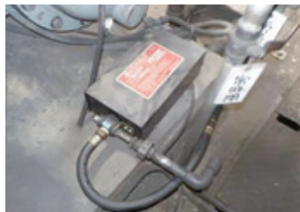
コンプレッサードレントラップ
