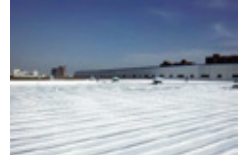
断熱塗装修繕後
