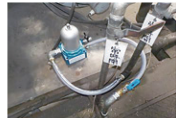
コンプレッサードレントラップ
